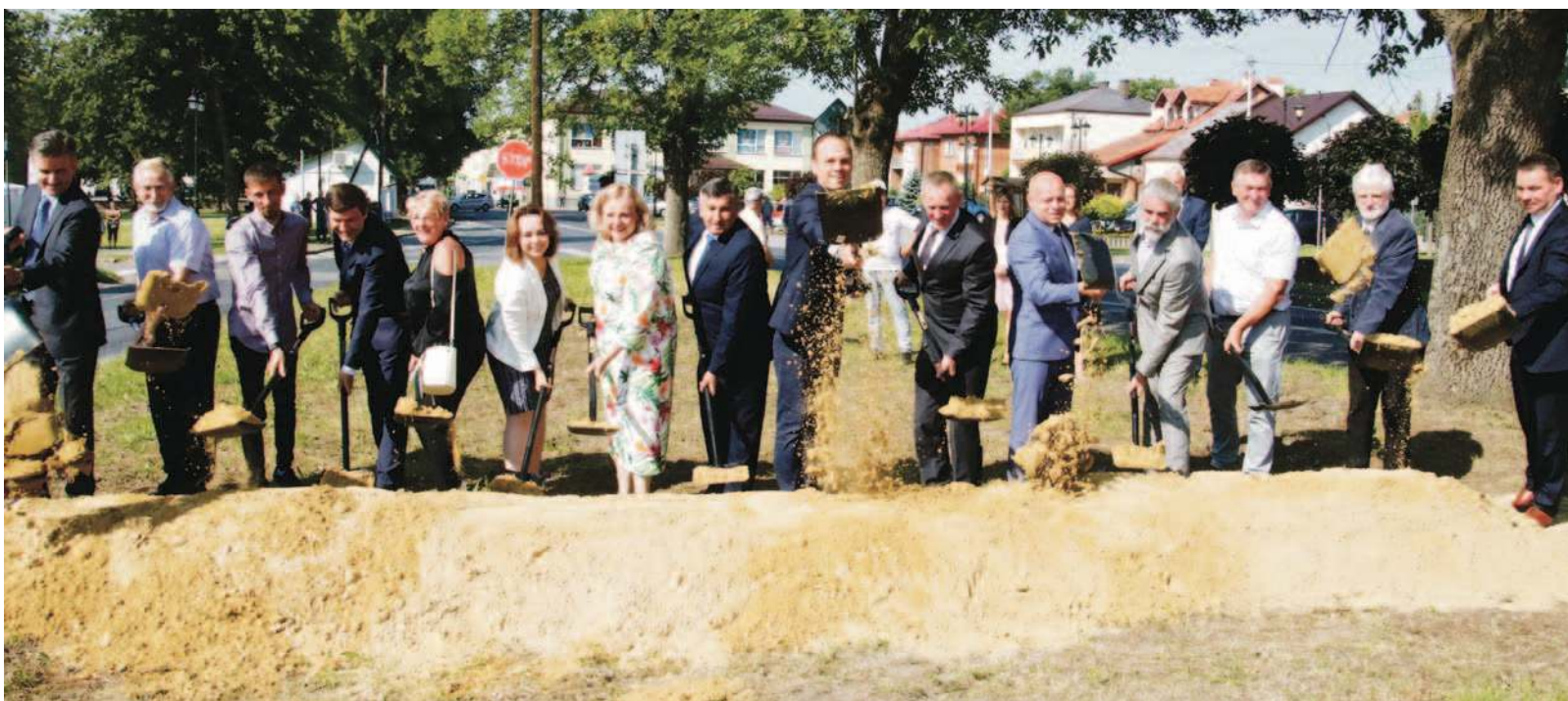
Budowa ronda rozpoczęła się symbolicznym wbiciem łopaty przez osoby, które zabiegały o poprawę bezpieczeństwa w ruchu drogowym na terenie Krzeszowa
