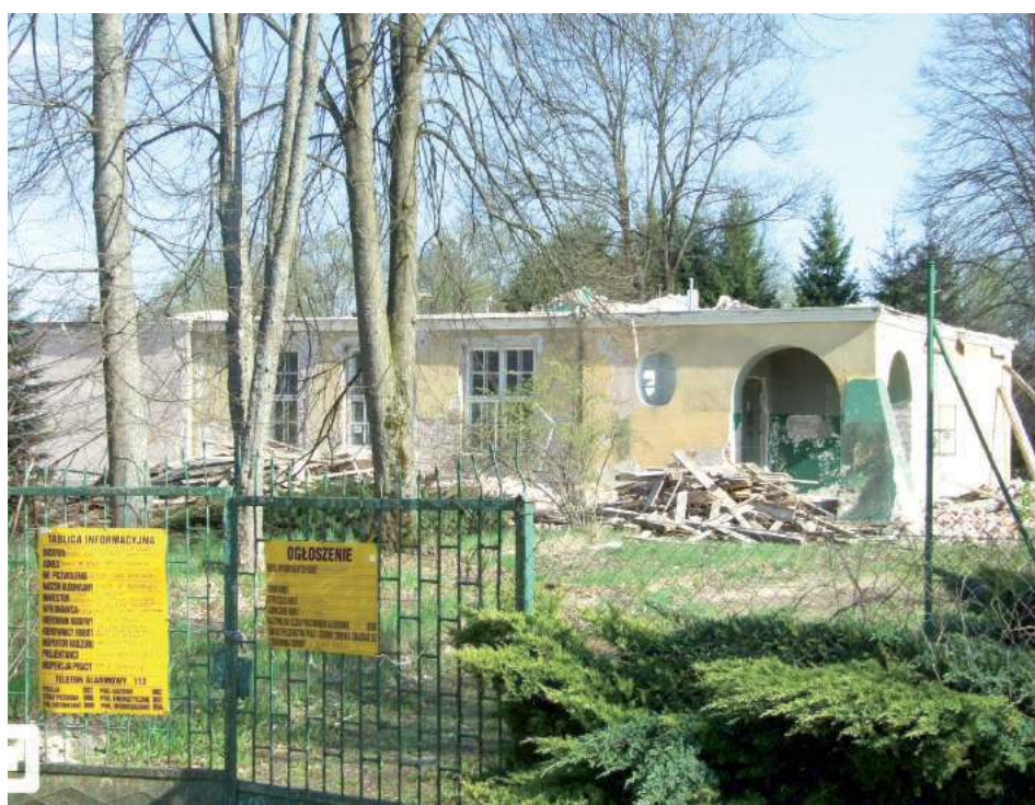
We wrześniu przyszłego roku w tym miejscu ma być gotowe nowe muzeum
