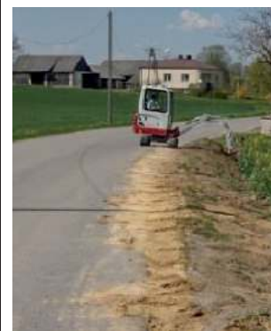
W Radzięcinie trwa już budowa nowego oświetlenia
