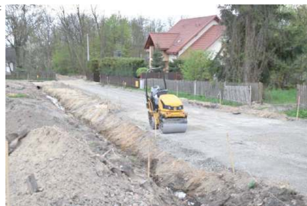
Długo wyczekiwana przez mieszkańców budowa drogi „za kościołem” w Majdanie Starym właśnie trwa
