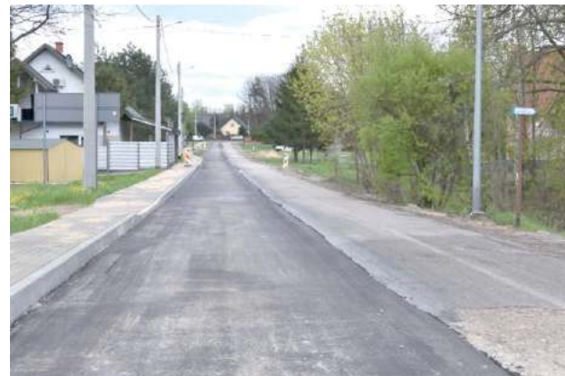
Ponad 2,3 mln złotych kosztować będzie modernizacja drogi gminnej w miejscowości Stare Króle oraz ulicy Nadrzecznej w Księżpolu
