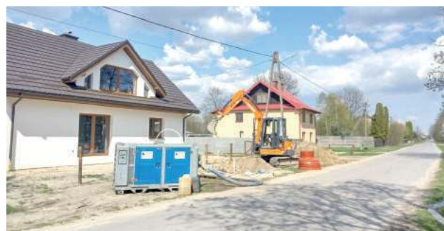
Jeszcze w sierpniu nowa kanalizacja będzie gotowa w Korytkowie Małym
