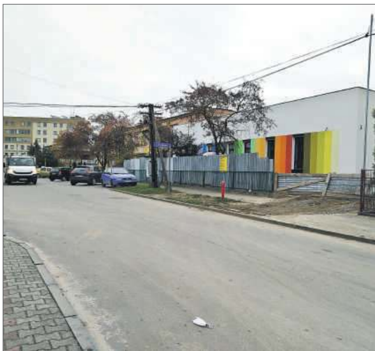
Burmistrz zapewnia, że ul. Kołłątaja, jak i inne, gdzie prowadzone są roboty, sprzątane są na bieżąco.
