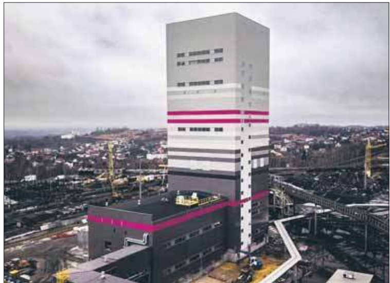
Budowa wieży szybowej ZG Janina
