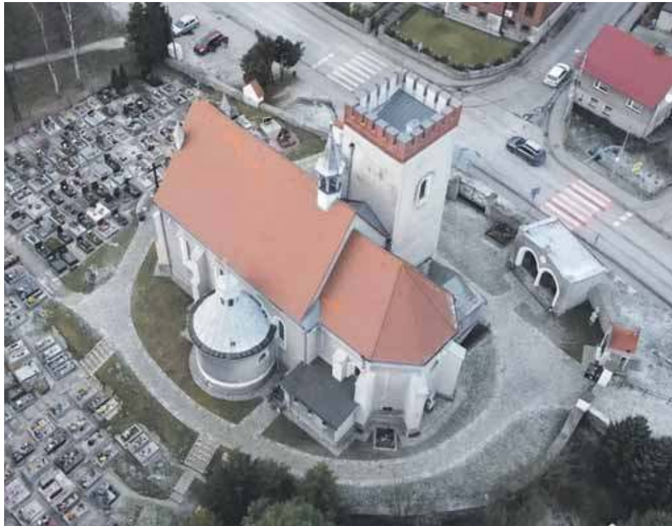
Przy ścianie południowej dobudowano kapliczkę, pod którą znajdował się grobowiec rodziny Strachwitz
