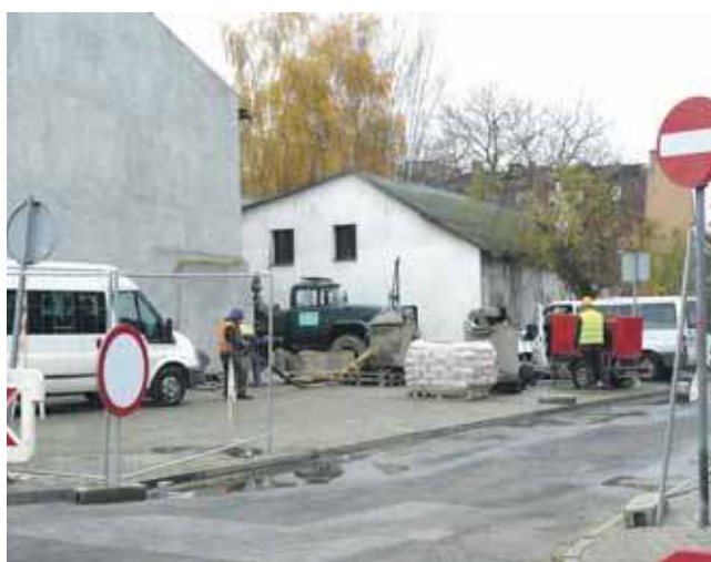
Prace prowadzone w listopadzie ubiegłego roku. Ciągu dalszego na razie nie ma i wciąż nie wiadomo, kiedy ten rejon miasta będzie w końcu przejezdny
