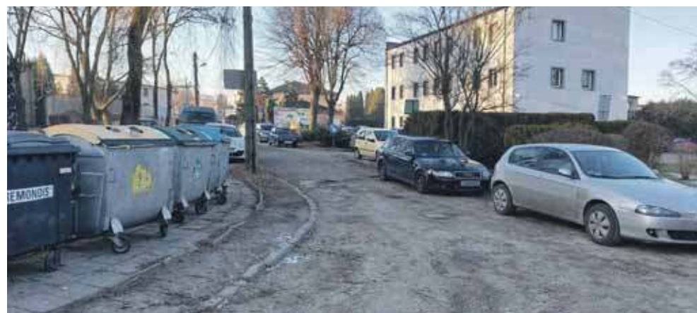
Ul. Młyńska w Świerklańcu. Radni mówią, że już najwyższy czas na remont
