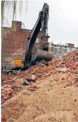
Rozbiórka kamienicy przy ul. Zachodniej
