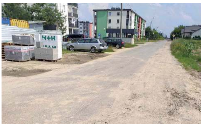
Ulica Podmiejska od wielu lat oczekiwała porządnego remontu
