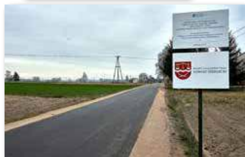
Droga powiatowa nr 3639W w miejscowości Modrzew
