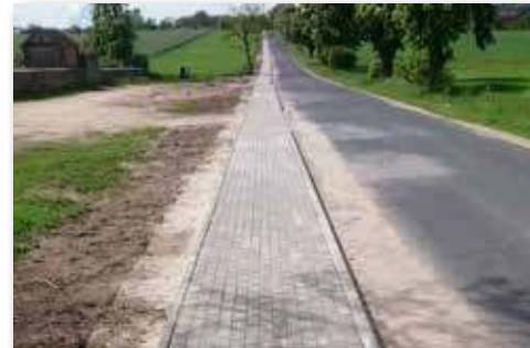
Chodnik w ciągu drogi powiatowej nr 3647 w miejscowości Wodynie
