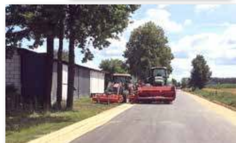
Droga powiatowa nr 3661W w miejscowości Wólka Proszewska
