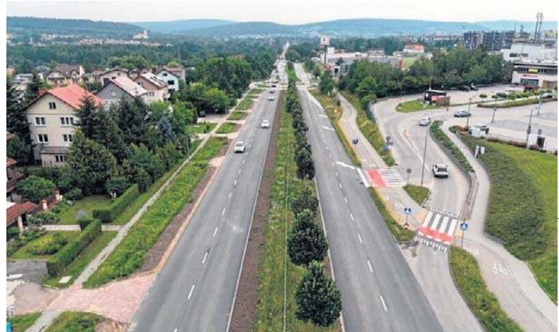
Zakończył się remont ulicy Warszawskiej na odcinku od ulicy Orkana do ronda Geodetów, przywrócono stałą organizację ruchu
