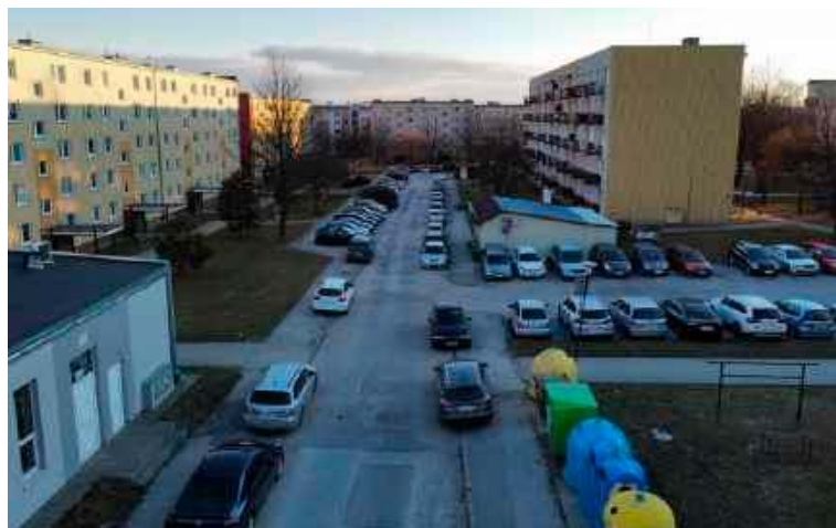
Dzięki przebudowie ulica Witosy nie tylko zyska równą nawierzchnię, ale również dodatkowe miejsca parkingowe
