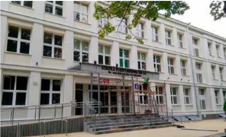
Nowa elewacja „Osiemnastki” cieszy oko
