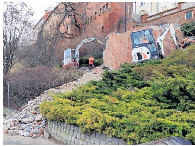
Stare schody zostały rozebrane do „zera”
