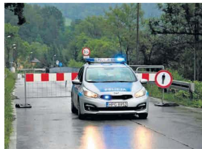
Od ponad miesiąca most na Kamienicy, łączący Nowy Sącz m.in. z gminą Kamionka Wielka, jest wyłączony z użytkowania
