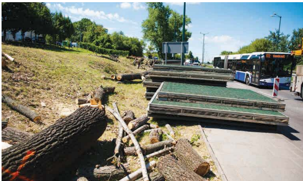
Wycięte drzewa i zdemontowane ekrany akustyczne to dowód, że budowa ruszyła
