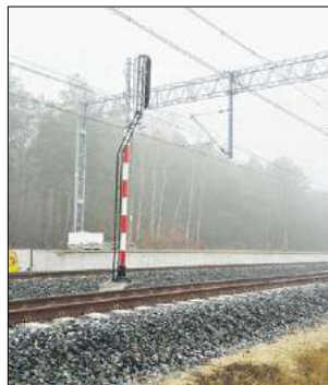
W ramach podpisanej 18 listopada umowy wykonawca zrealizuje również budowę przejścia pod torami na nowym przystanku Biała Podlaska Wschodnia
