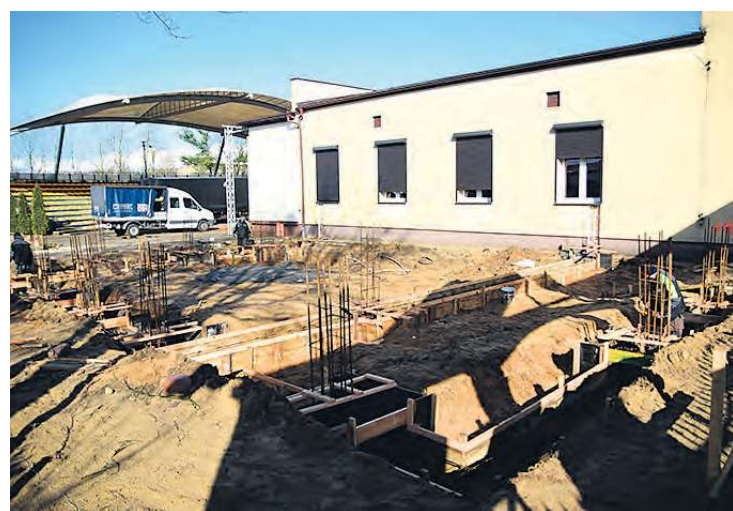
Rozbudowa trwa. Termin zakończenia prac mija 30 czerwca.
