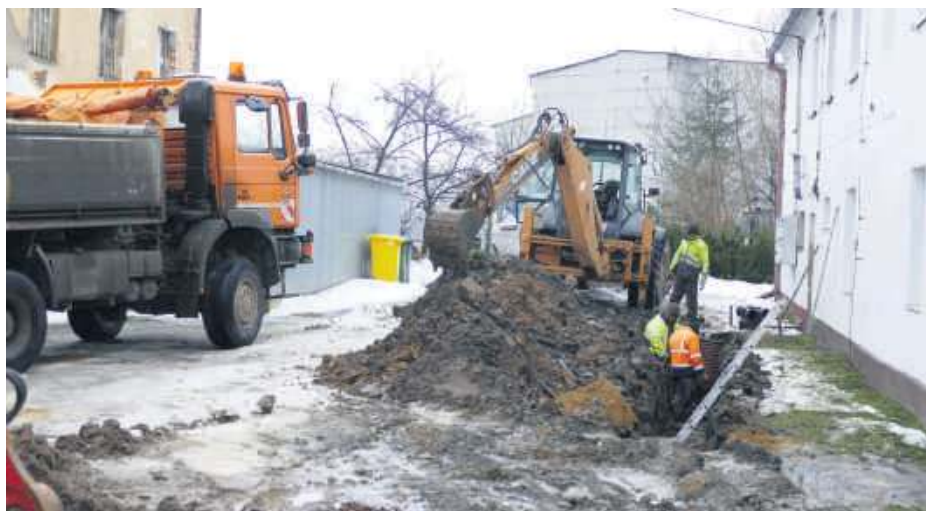
Pracownicy ZUK-u Przeworno wykonali nowe przyłącze do bloku „na młyńce”
