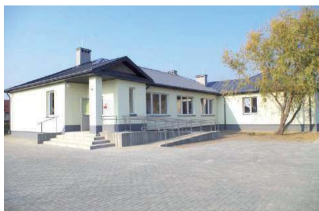
Świetlica wiejska w Żerdzi jest już gotowa. Budynek czeka jeszcze na doposażenie i oficjalne otwarcie
