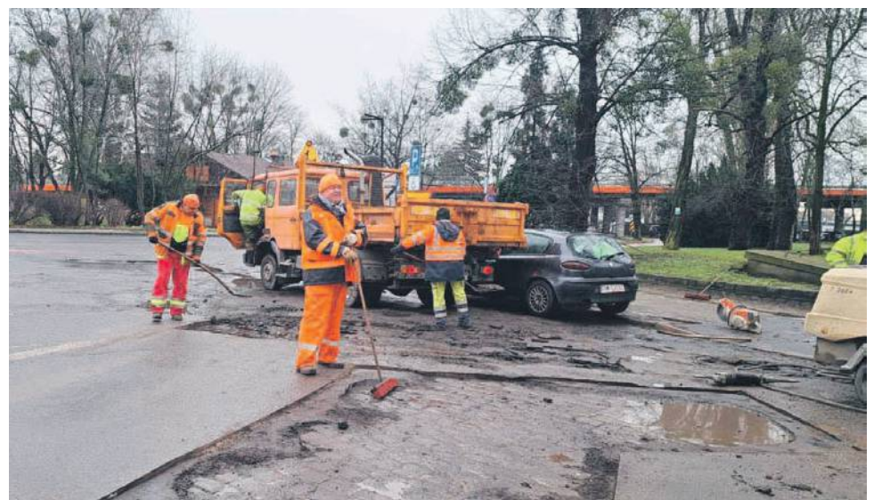
Miejmy nadzieję, że teraz przez jakiś czas, czyli do rozpoczęcia planowanego remontu stacji PKP, kierowcom będzie tu łatwiej
