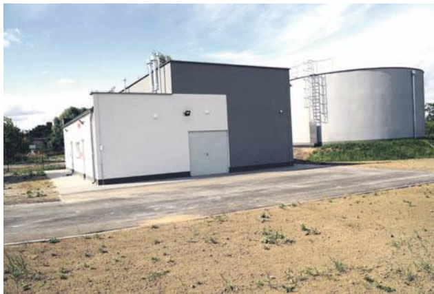
Stacja Uzdatniania Wody w Sobocisku
