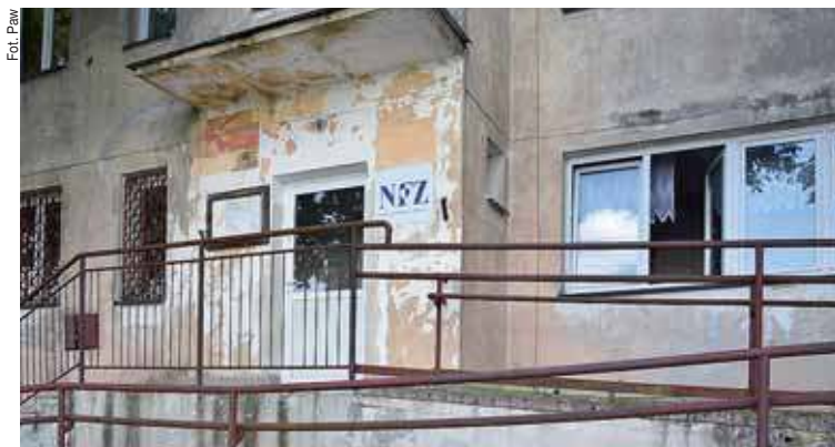
Budynek gdzie znajdował się będzie ośrodek zdrowia
