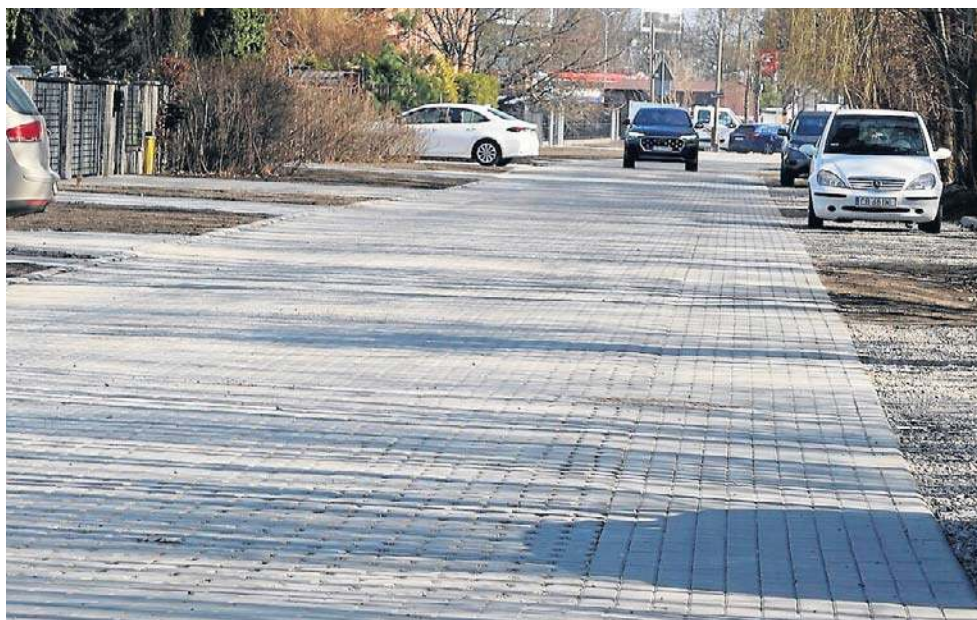
Nowe kryteria utwardzania dróg gruntowych dotyczą inwestycji w latach 2027-2030
