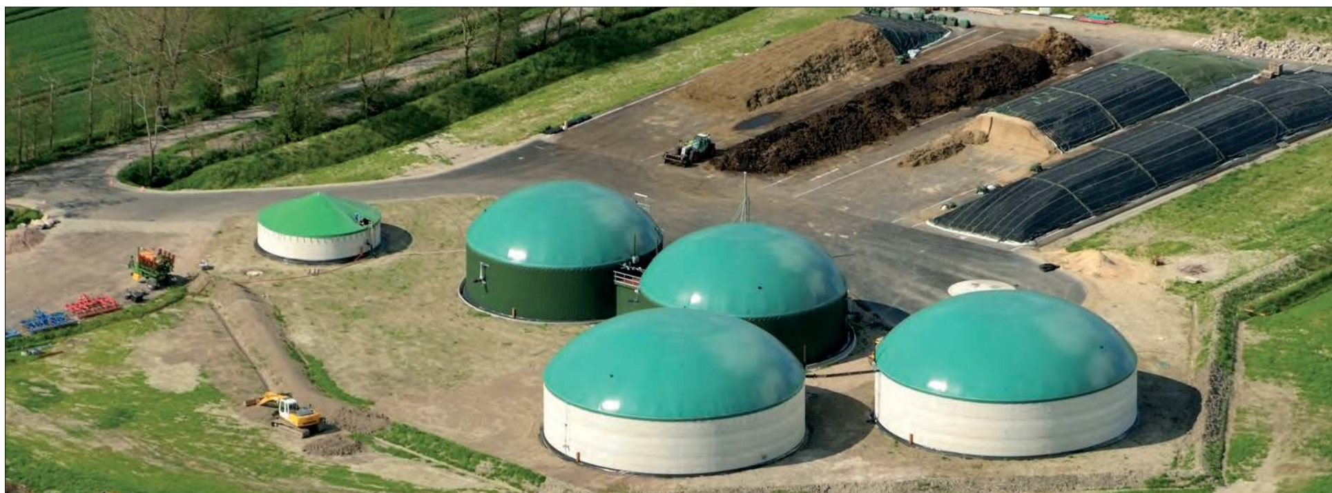
Biogazownia w Bremerhaven w Niemczech
