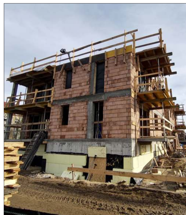
Na Smoczce rośnie budynek mieszkalny.
