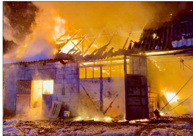
Pożar objął cały budynek gospodarski.
