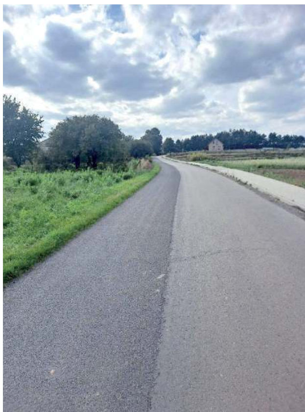
Fragment remontowanej ulicy Poprzecznej w Dysie. Ciemniejszy pas z lewej strony to nakładka z emulsji i gryzu. Po prawej stronie stara nawierzchnia asfaltowa
