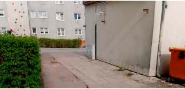
Prowizoryczny wjazd na parking, póki co, pozostanie w takim stanie
