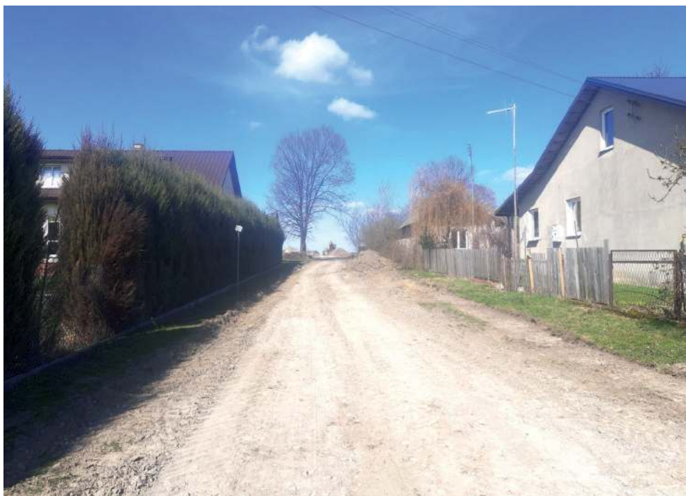
Tak wyglądają prace nad nową odcaloną „Gościńca” w Woli Osińskiej. Mieszkańcy są bardzo zadowoleni z tego, że ich miejscowość doczeka się drogi z prawdziwego zdarzenia
