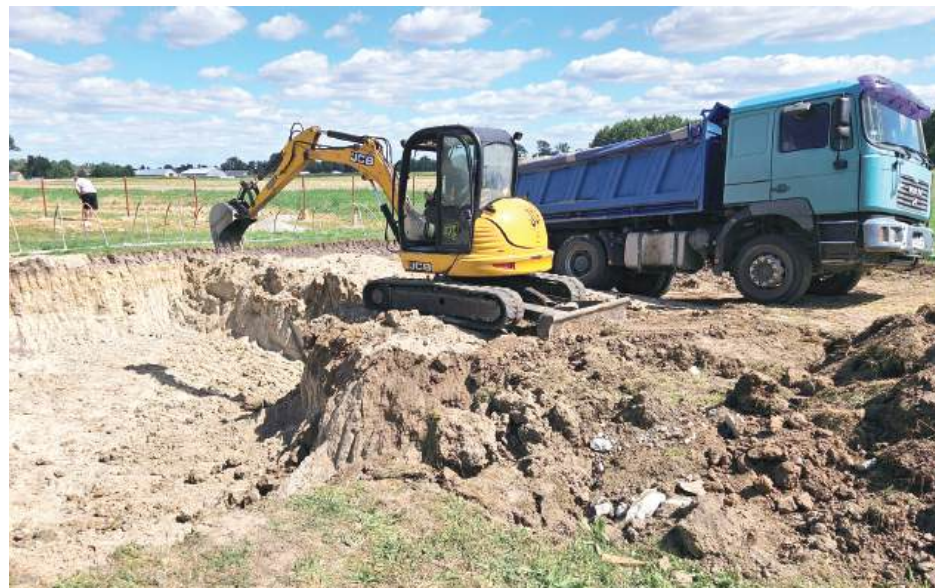
Na placu budowy rozpoczęto już prace
