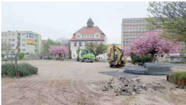
Fragmenty rozebranego bruku podjęte przez ciężki sprzęt od strony północnej Placu Wolności
