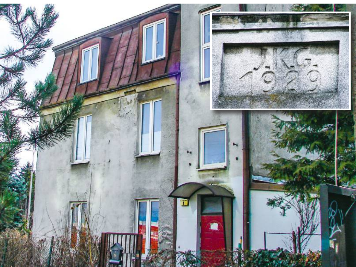
Dom przy ul. Łobeskiej 1 i fragment elewacji z datą jego wzniesienia
