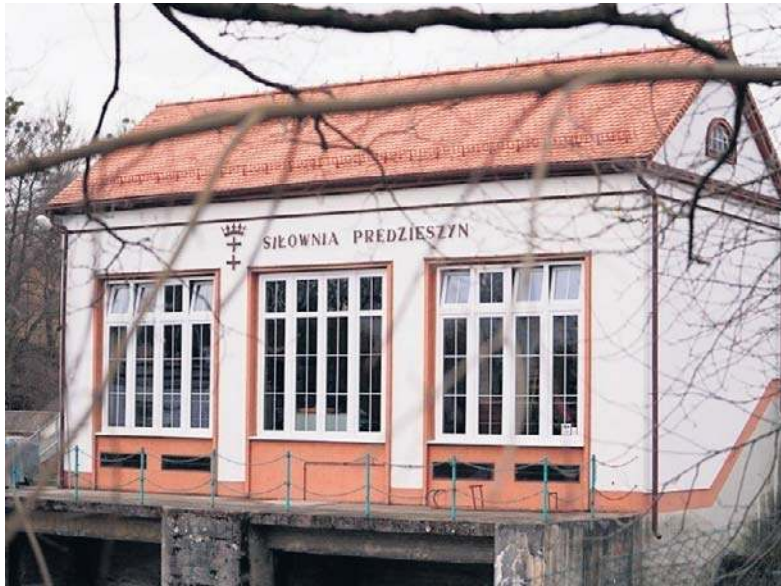
Elektrownię wodną w Przędziszynie uruchomiono w 1937 r.
