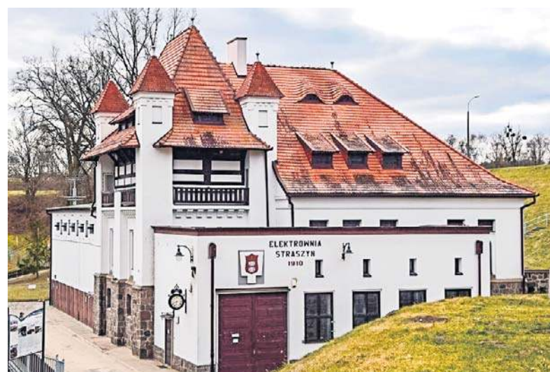
Elektrownię w Straszynie uruchomiono w październiku 1910 roku jako pierwszą siłownię na rzece Raduni
