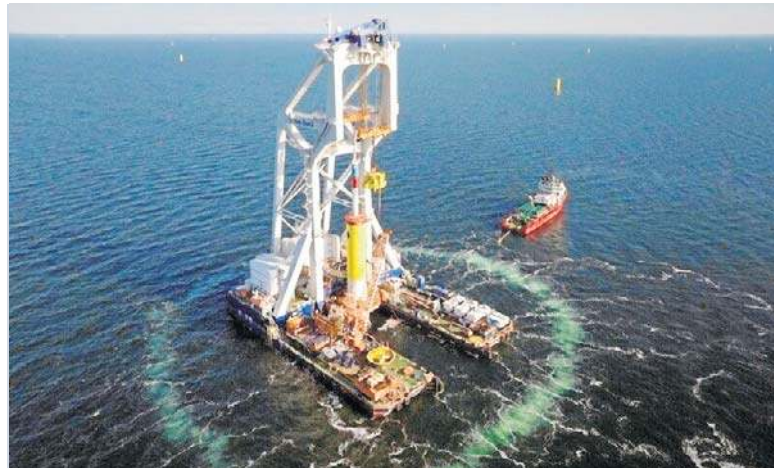
PGE i Orsted zakończyły instalację fundamentów dla morskiej farmy Baltica 2
