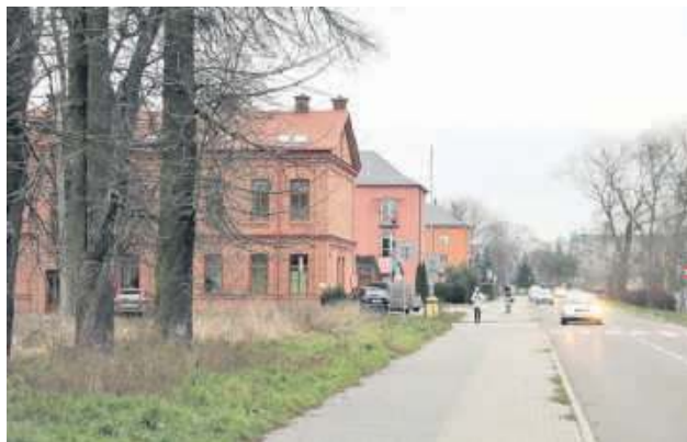
Dawne budynki koszarowe przy ul. Kamiennej.
