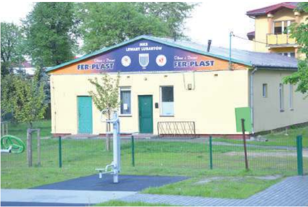
Sportowcy trenują w baraku przy Krzywym Kole, budowa nowego obiektu pozwoli im się przenieść
