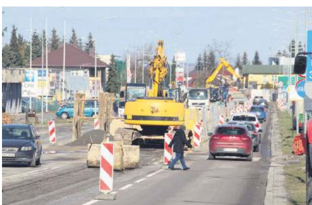
Remonty na ul. Lubelskiej w Zamościu trwają.
