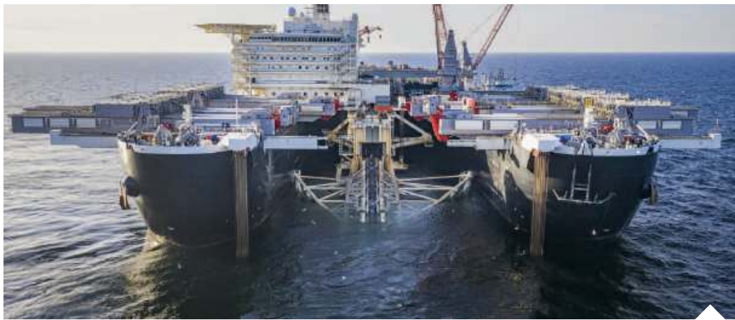
Wycofanie się USA z sankcjonowania projektu Nord Stream 2 przekreśliło jakiekolwiek nadzieje, że zostanie on wstrzymany | fot. Axel Schmidt/Nord Stream 2/d
