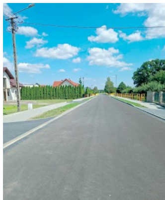
Wyremontowana droga w Makowcu (fot. UG Szelków)
