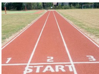
Gmina Joniec zakończyła budowę bieżni
