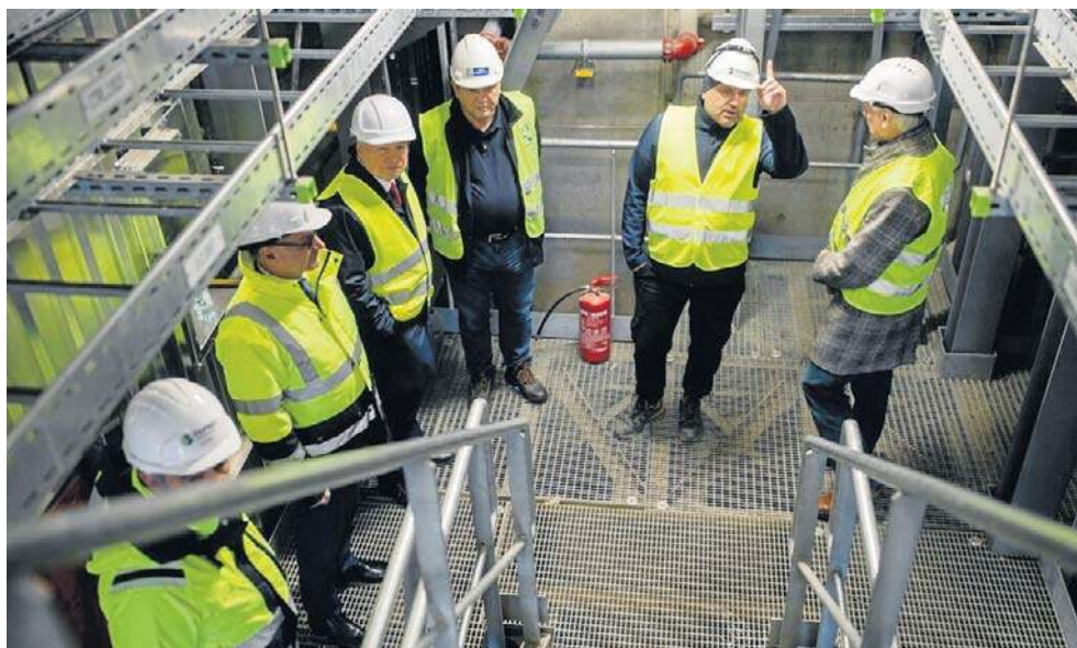
Budowa spalarni rozpoczęta w 2022 r., miała zakończyć się we wrześniu 2024 r.
