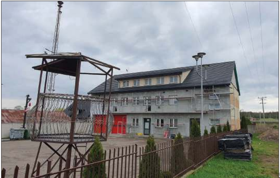
Bocianie gniazdo zostało zdemontowane. Nie wróci już na dach budynku
