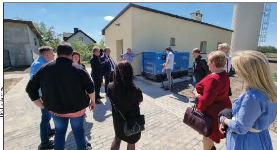
Prace zostały już zakończone i odebrane
