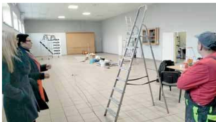
Ośrodek Kultury w Przybiernowie jest remontowany (fot. OK Przybiernów)
