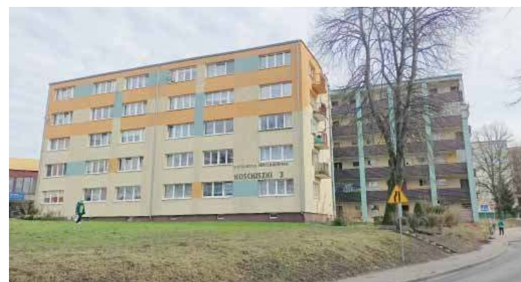
Blok przy ul. Kościuszki 3 po raz kolejny jest bohaterem naszego artykułu
