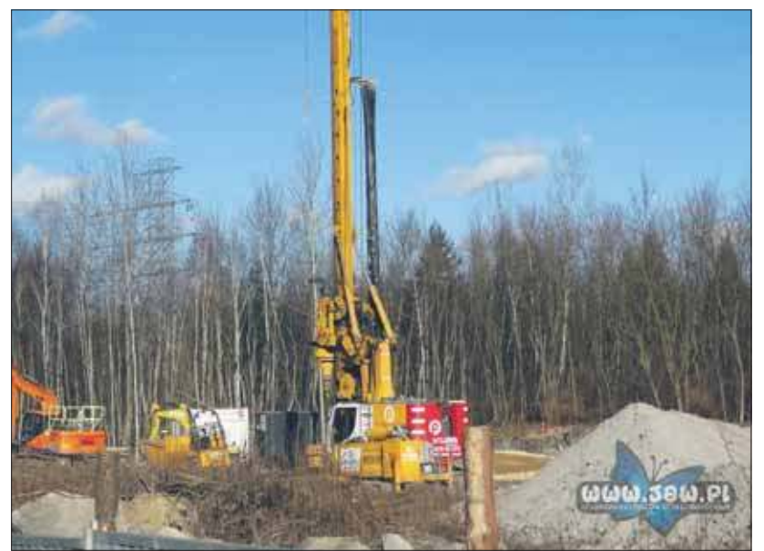
Budowa SUW „Jan Kanty”
