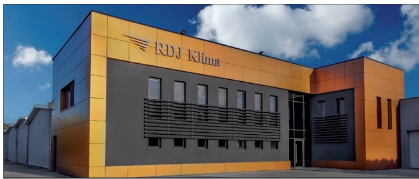
Fot. 1. Widok administracyjno-biurowej części budynku
