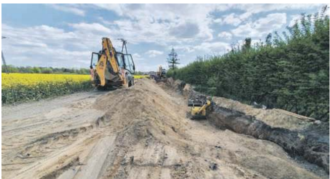
Budowa kanalizacji deszczowej
