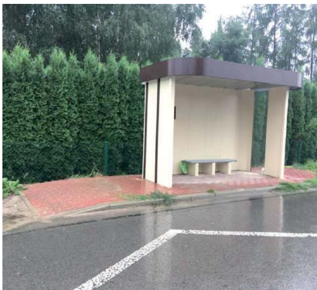
Część mieszkańców Bronowic nie będzie musiała już czekać na „emkę” w deszczu. Nowy przystanek autobusowy został zrealizowany dzięki funduszom sołeckim na ten rok
