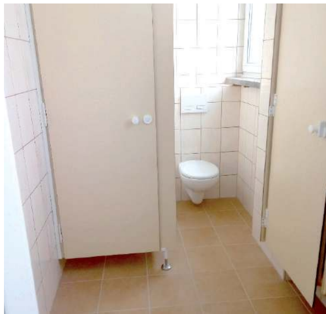
Wymianie na nowe uległy również stare kabiny
