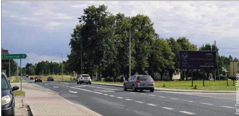
Nowa droga krajowa nr 9 już neibawem ma stać się faktem.
