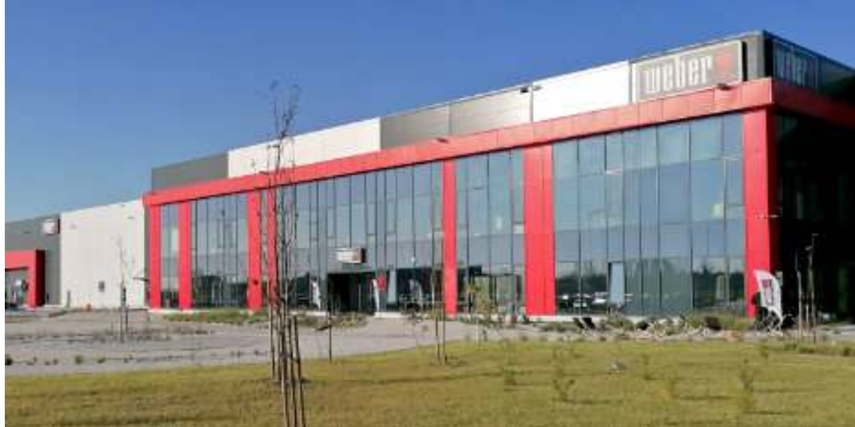
► Budowa kompleksu trwała zaledwie rok Fot. Igor Cieśllicki
