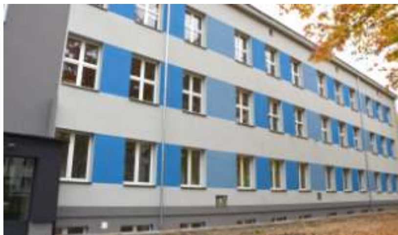
► Wyremontowany budynek szkoły Fot. UM Zabrze
