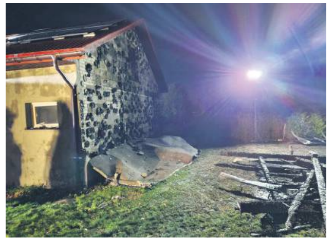
Ze zgłoszenia wynikało, że zagrożone są sąsiednie budynki.
