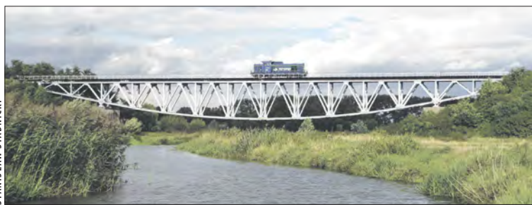
Most kolejowy na Osoblodze
