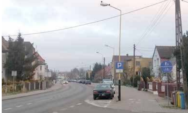
Pracami zostanie objęta m.in. ulica Bohaterów Warszawy
