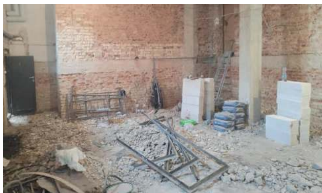
Na razie prowadzone są głównie prace rozbiórkowe
