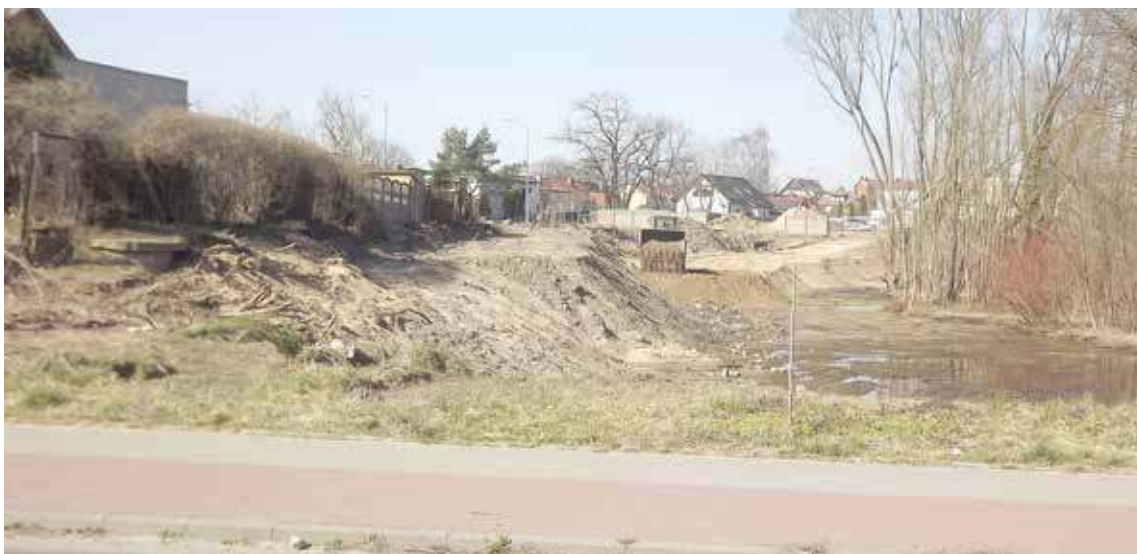
W tym miejscu z ul. Nowogardzką połączona zostanie ul. Metalowa. Trwa usypywanie przebiegu łącznika
