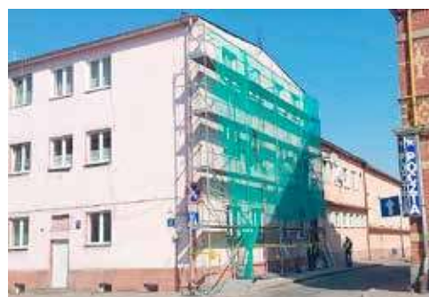
Budynek na Wojska Polskiego przechodzi drobny, estetyczny remont elewacji (fot. Gmina Maszewo)
