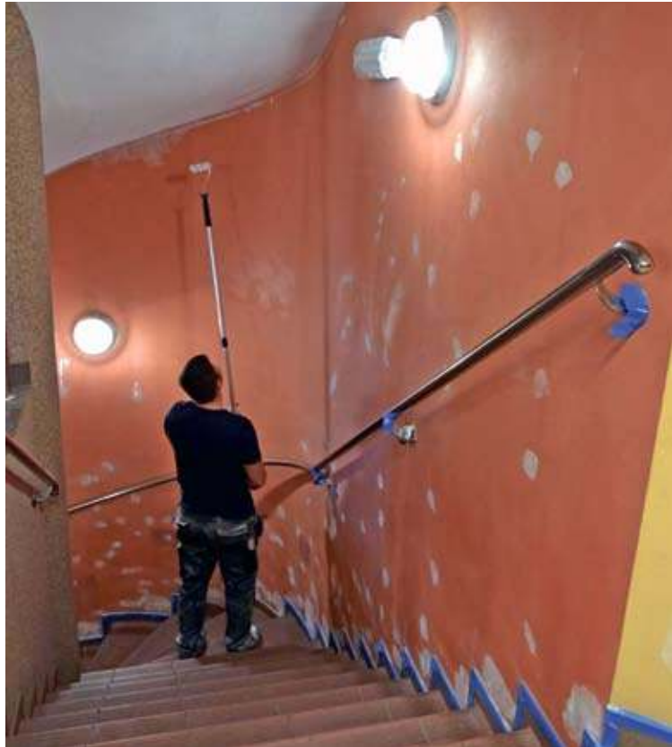
Zniszczone pomieszczenia zostały odmalowane
