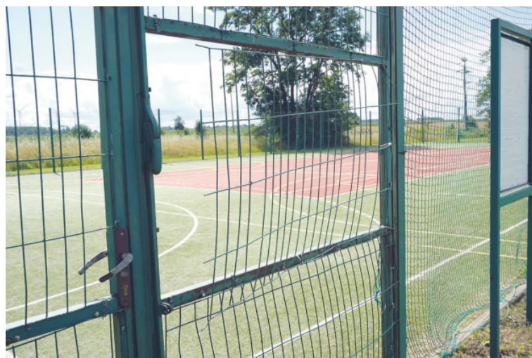
Ogrodzenie Orlika wymaga pilnej naprawy.
