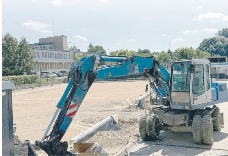
Na razie przy ZS nr 2 trwają prace przygotowujące teren pod halę sportową. fot. MC
