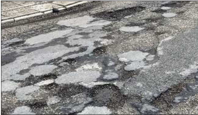
Tak wygląda jezdnia po remoncie (Gwoźdźce).
